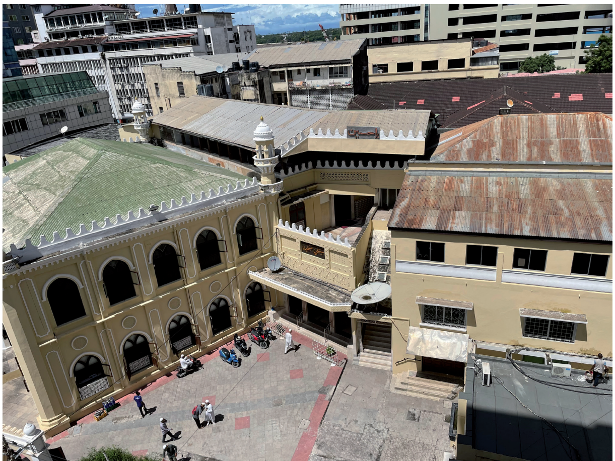
Fig. 6: Saifee Masjid, Dar es-Salaam. Foto af Cecil Pallesen 2022.
